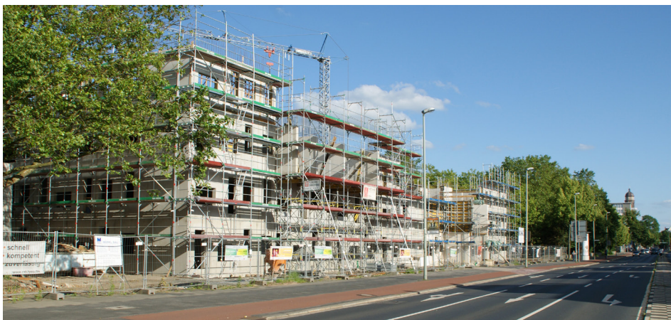
Baustelle des LSGs im Juni 2012 | Foto: Christian Zigenhorn
